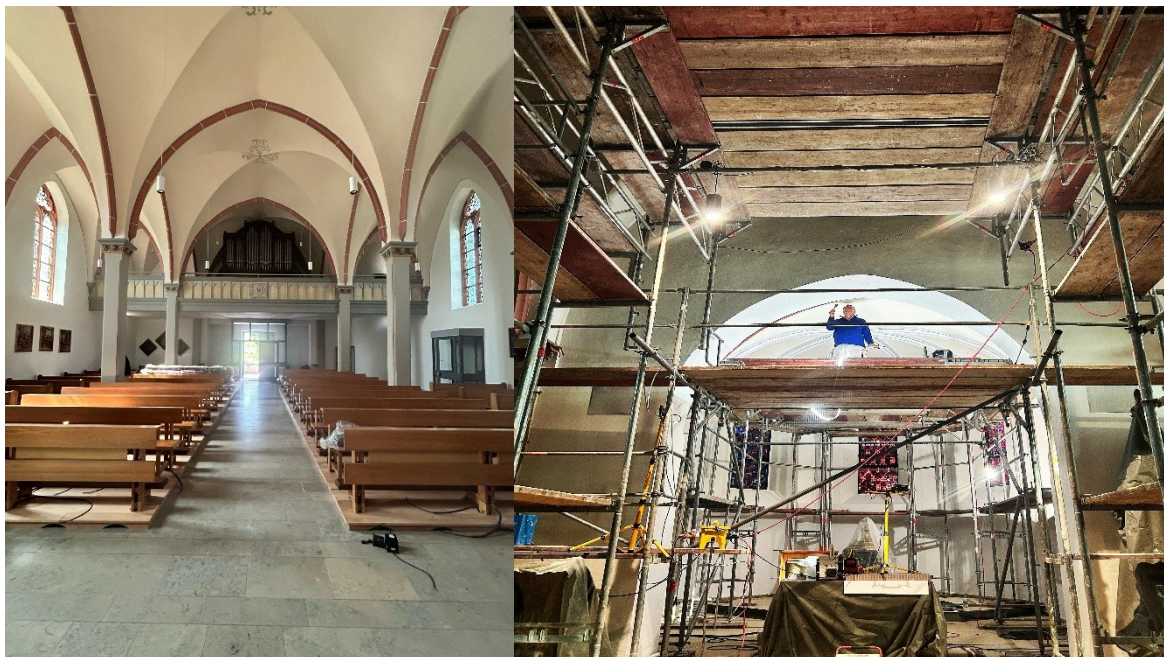
Bilder aus der Bauphase - co Silke Herchenbach
